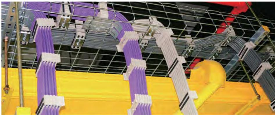
通信业务线缆在其弯曲半径于合理范围内进行布线及端接，使得每根线缆长短统一，以达到美观的效果。
